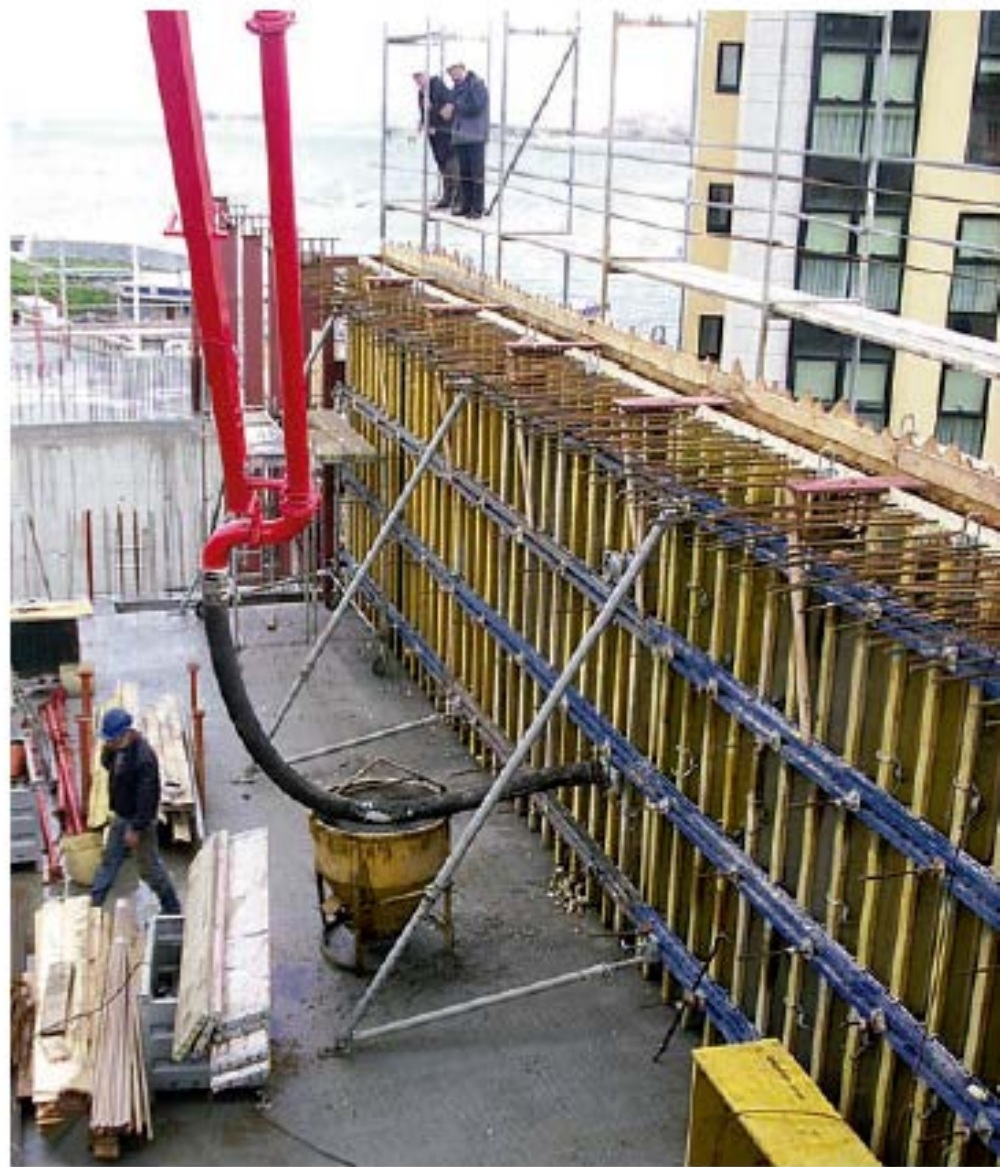
Figura 3.- Encofrado preparado para colocar el hormigón autocompactante mediante bombeo y de abajo hacia arriba.
