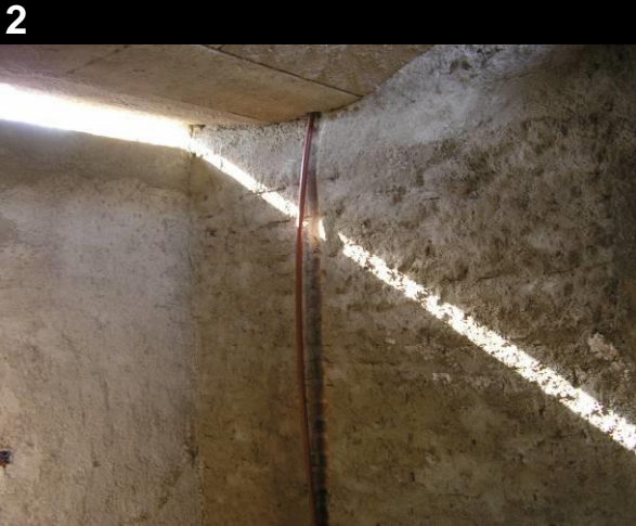
Cuchareado hidrófugo (cemento y agua) interior con castigado de mortero 1-3 (cemento arena gruesa)
