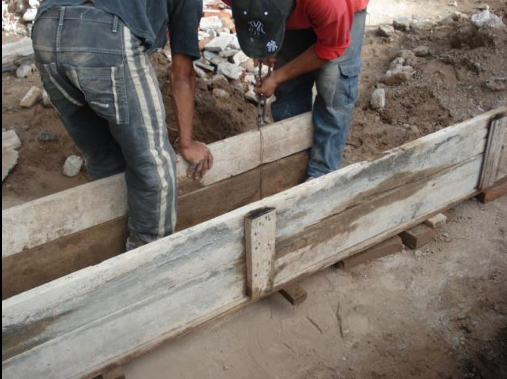
Armado del encofrado para columna de encadenado
