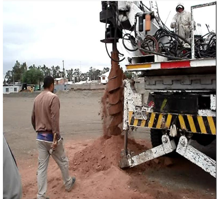
PILOTERA EXCAVANDO Y EXTRAYENDO EN SUELO SECO
