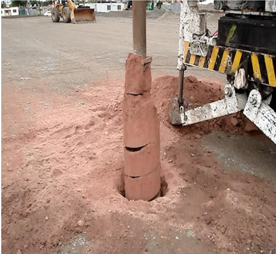
PILOTERA EXCAVANDO Y EXTRAYENDO EN SUELO SECO
