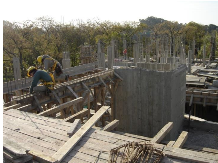
Armado de encofrado en altura
