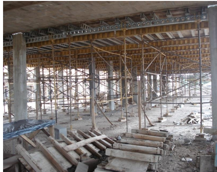
Puntales metálicos , banquetas y base de losas
