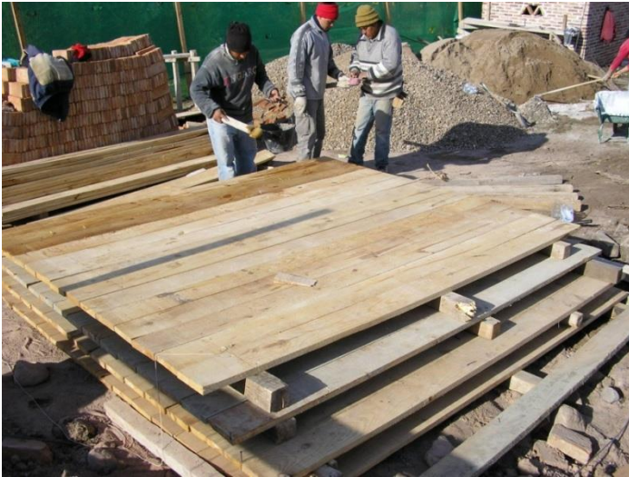
Encofrado de viga
