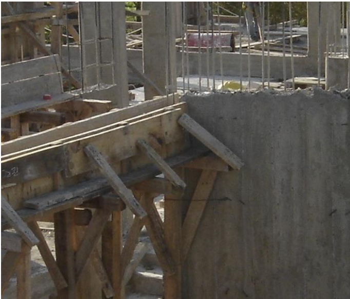
Encofrado de viga
